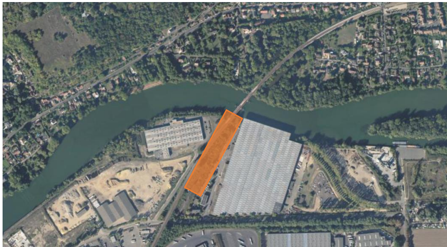
Vue aérienne de l'emprise SNCF Réseau (orange) pressentie pour accueillir les opérations de préfabrication du nouvel ouvrage et d'évacuation de l'ancien pont-rail.
