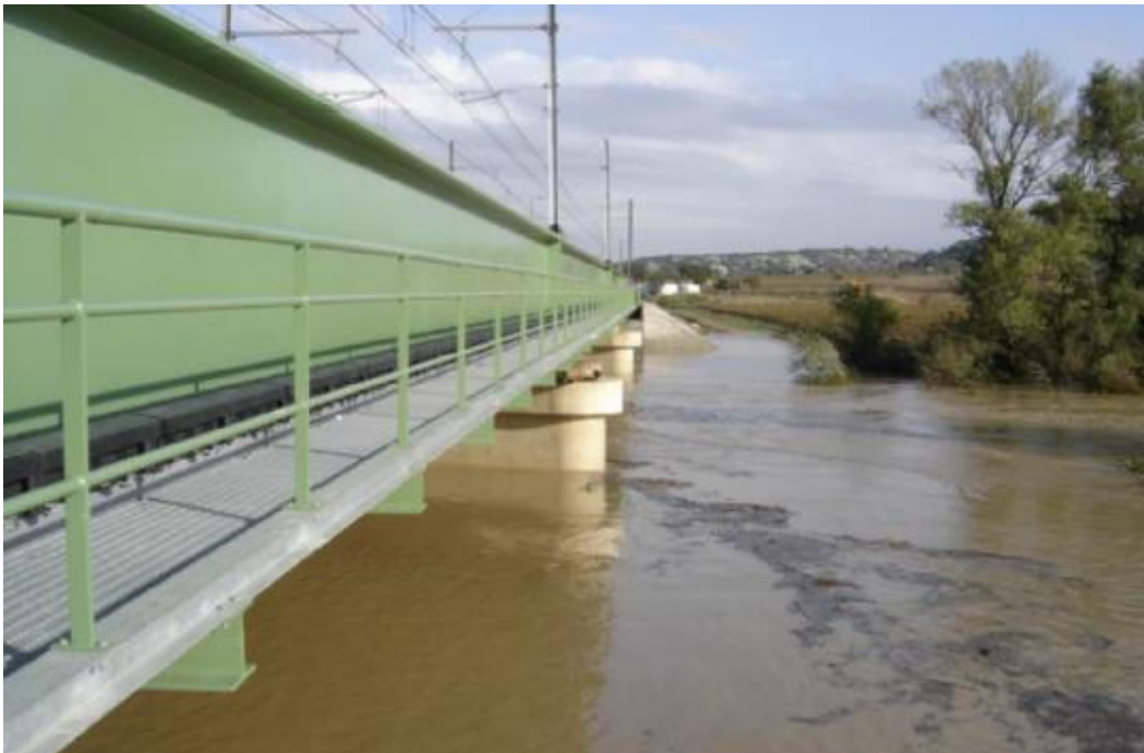
Exemple d'un pont-rail à poutres latérales hautes
